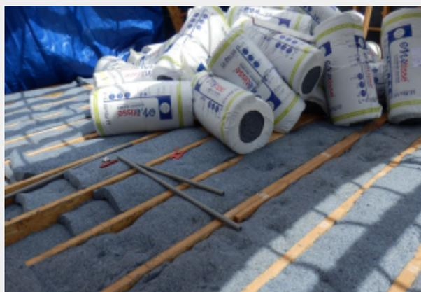
Isolant en Métisse issu de textile recyclé
