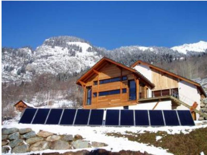
Le chauffage de l'habitat est réalisé par le biais d'une circulation de l'eau chaude au sein d'un plancher qui permet de stocker l'énergie dans l'habitat. Il peut également y avoir un stockage de la chaleur dans un ballon avant d'être diffusée.
