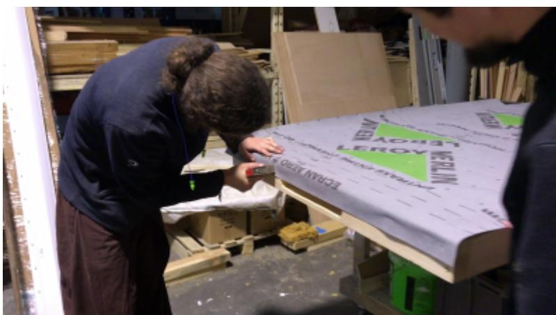
Ouvrir le pare-pluie au niveau de l'entrée et de la sortie d'air à l'aide du cutter.
