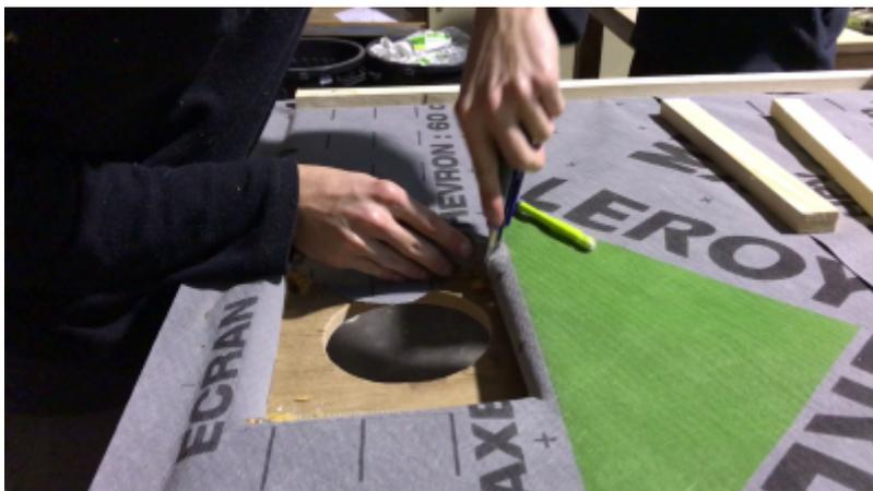
Afin de plaquer le parepluie, des baguettes sont vissées sur le cadre.
