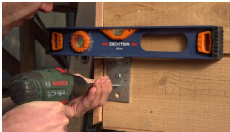
Installer le capteur en veillant à que le coffrage soit correctement plaqué sur le panneau. Fixer le panneau en utilisant les équerres installées sur le mur à l'aide de chevilles.
